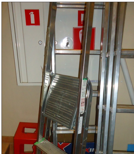
Ugunsdzēsības līdzekļu pieejas vietās aizkraušana rada risku novēlotai rīcībai un nelaimes gadījumiem
