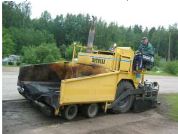
3.2.attēls. Asfalta ieklāšanas process
