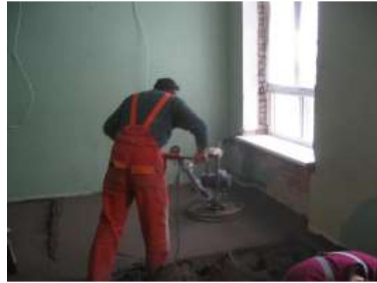
2.4.attēls. Betona izlīdzināšanas process
