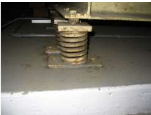
11.1.attēls. Vibrācijas dzēšana, izmantojot atsperes
