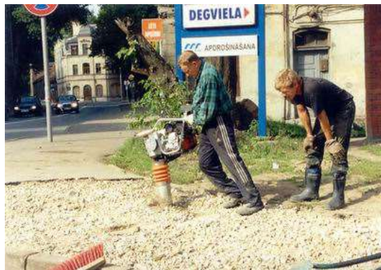
2.2.attēls. Šķembu blietēšana ar vibroblieti.
