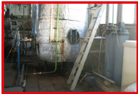
Pārvietojamo kāpņu izmantošana piekļuvei iekārtām rada augstāku nelaimes gadījumu risku
