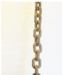
Korozijas rezultātā metāla virsma nav gluda
