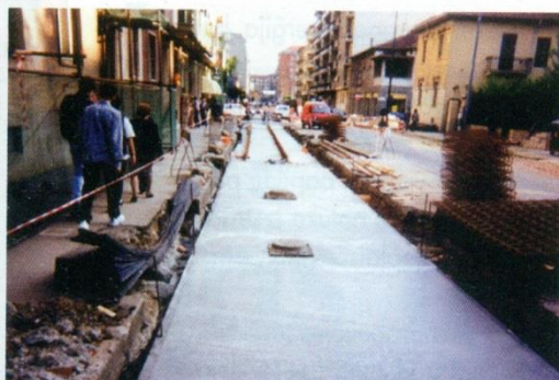
Sliežu transporta līnijas pamatnes izveide uz skaņu izolācijas materiāla kārtas
